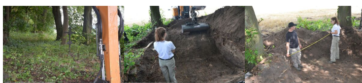
Prace BPil w Małkowie-Kolonii
