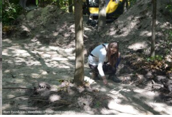
Prace w miejscowości Wyrąb
