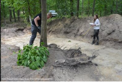
Prace w miejscowości Wyrąb
