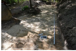
Prace w miejscowości Wyrąb
