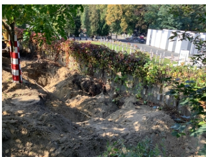
Prace za murem cmentarza wojskowego na Powązkach
