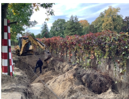
Prace za murem cmentarza wojskowego na Powązkach
