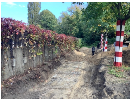
Prace za murem cmentarza wojskowego na Powązkach
