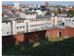
Bydgoszcz: prace na terenie Aresztu Śledczego
