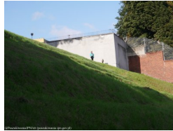
Bydgoszcz: prace na terenie Aresztu Śledczego
