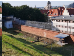
Bydgoszcz: prace na terenie Aresztu Śledczego
