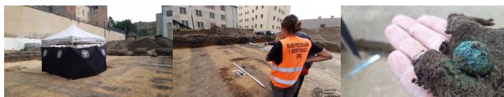
Prace ul. Rakowiecka #13
